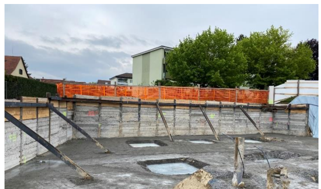
Abbildung 2: Abgestützte Rühlwand
