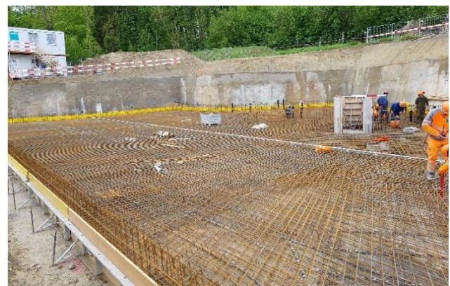
Abbildung 3: Bewehrung Bodenplatte mit Nagelwand (hinten)
